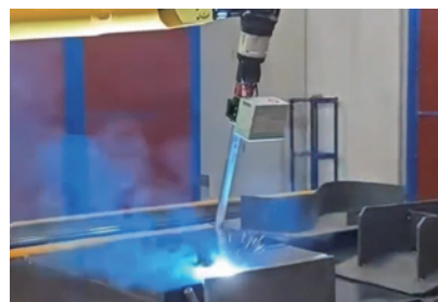
多层多道焊接
