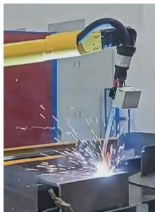
多层多道焊接
